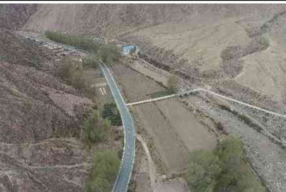
1#弃渣场复耕情况
