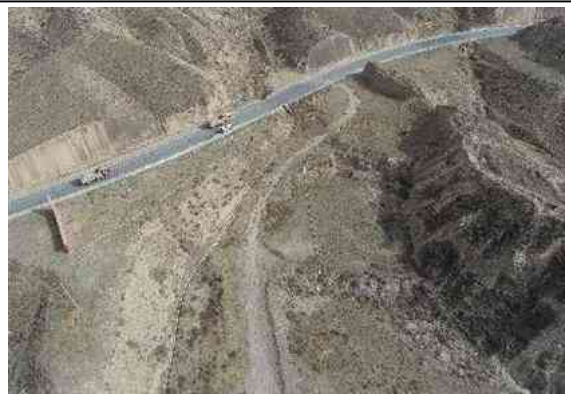
施工场地恢复情况
